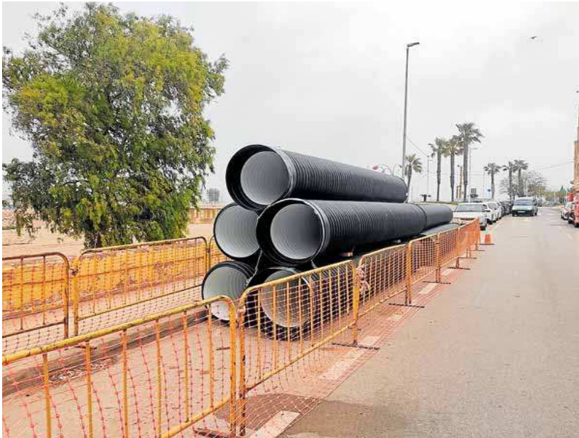
Las obras en la Ronda Malecó de Carlet ya han comenzado. A. T.
